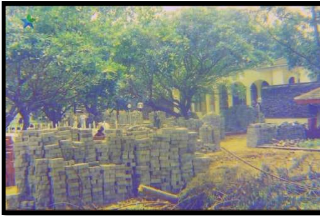
Gambar 10.11. Pemasangan paving block di area Taman Makam Pahlawan Taruna tahun 1995. (Sumber: Khastara Perpunas)
