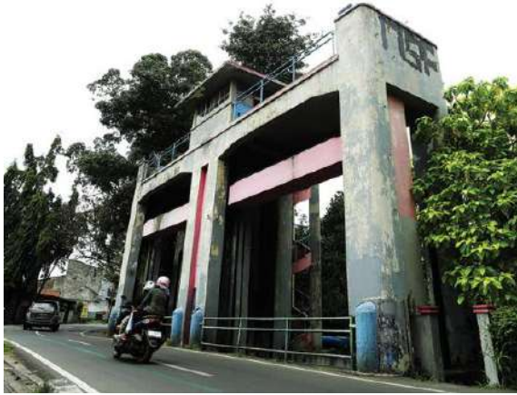
Gambar 9.23. Pintu Air Kecil atau Pintu Air Sewan
