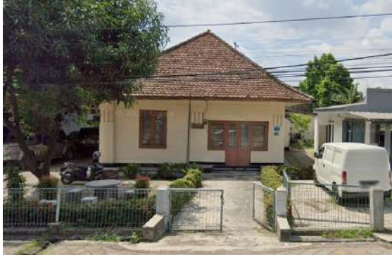
Gambar 9.31. Salah satu bangunan rumah eks-pegawai lapas
