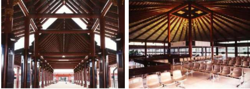
Gambar 3.6. Atap selasar dan lobi terminal bandara tersusun atas pipa-pipa besi berlapis cat merah menyerupai warna kayu-kayu atap pendopo dan Joglo. Sumber: Gregorius Antar, AKA
