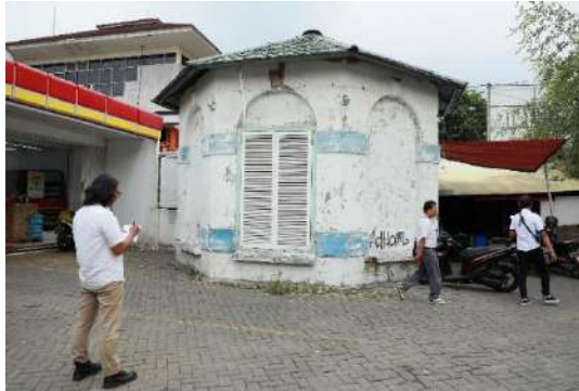
Gambar 9.30. Rumah Telepon di Jalan Daan Mogot
